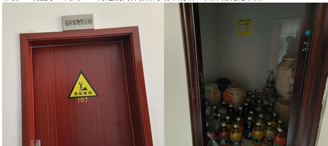
图 2.4 现有项目危废暂存间
