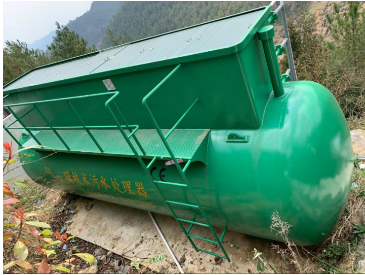
图 3.4-1 龙缸景区内膜技术污水处理器
