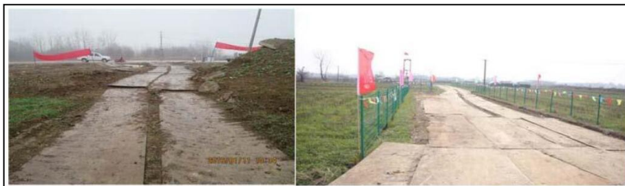
图5-2 临时道路铺设钢板实例示意
