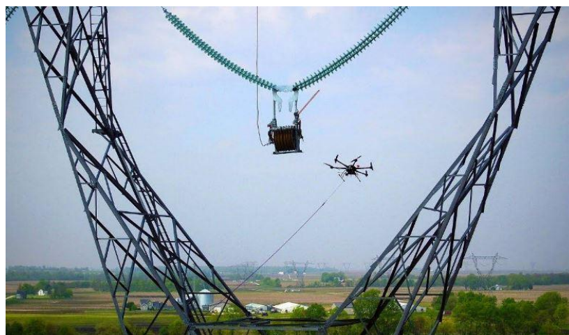
图 5-7 无人展放初级牵引绳示例
