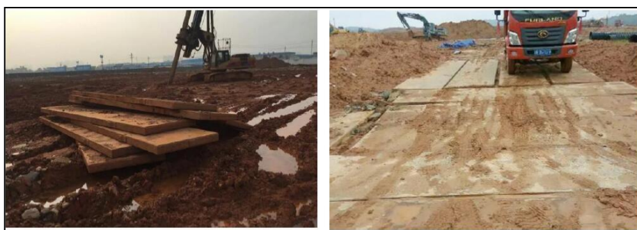
图5-3 临时道路路基箱铺设实例示意
