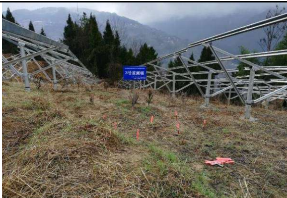
相似工程施工现场
