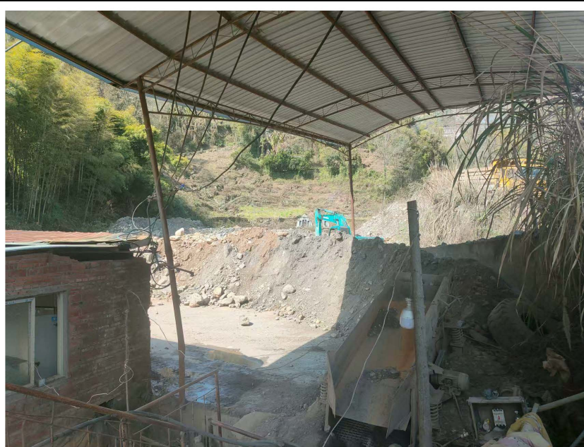
依托钢结构厂房现状照片
