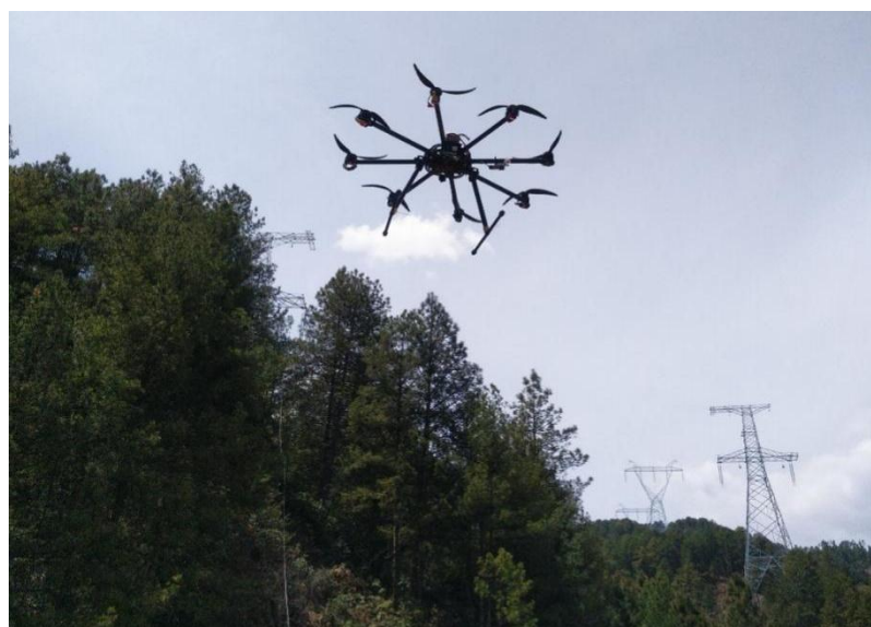
图 2-3 无人机放线施工示例
