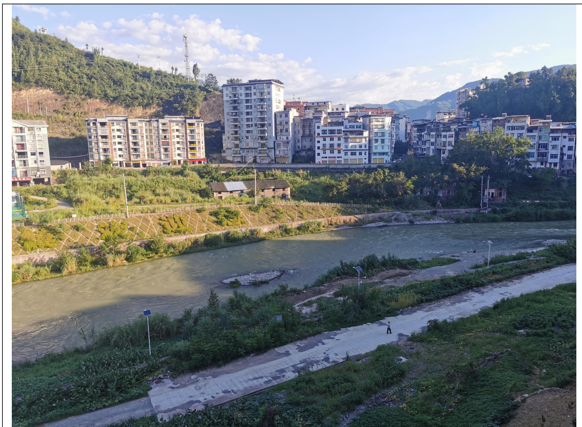
工程上段生态措施恢复现状图
