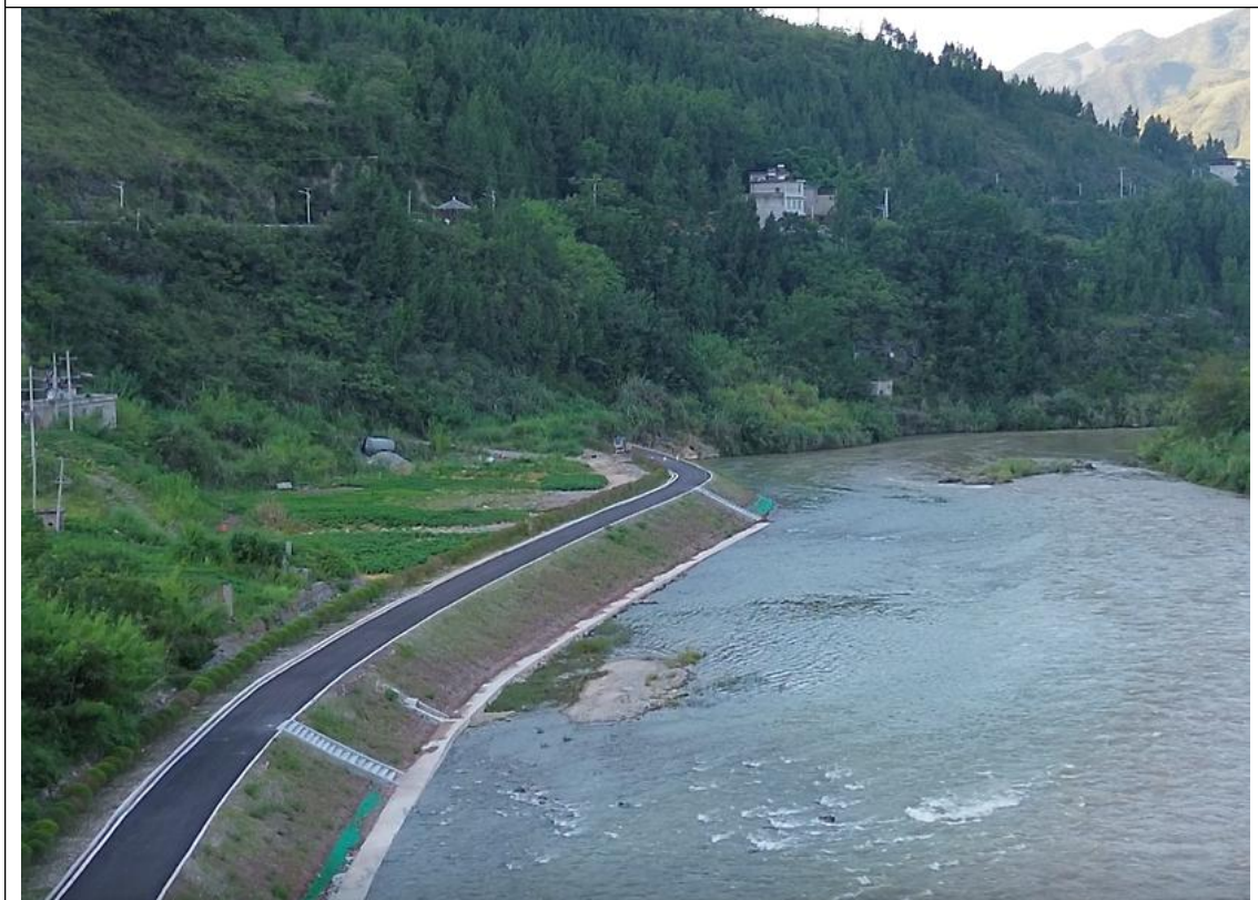
工程上段生态措施恢复现状图
