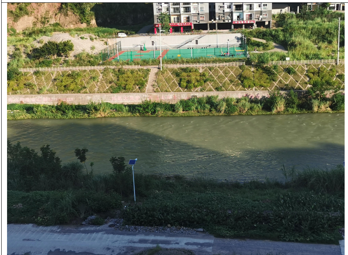
工程中段生态措施恢复现状图
