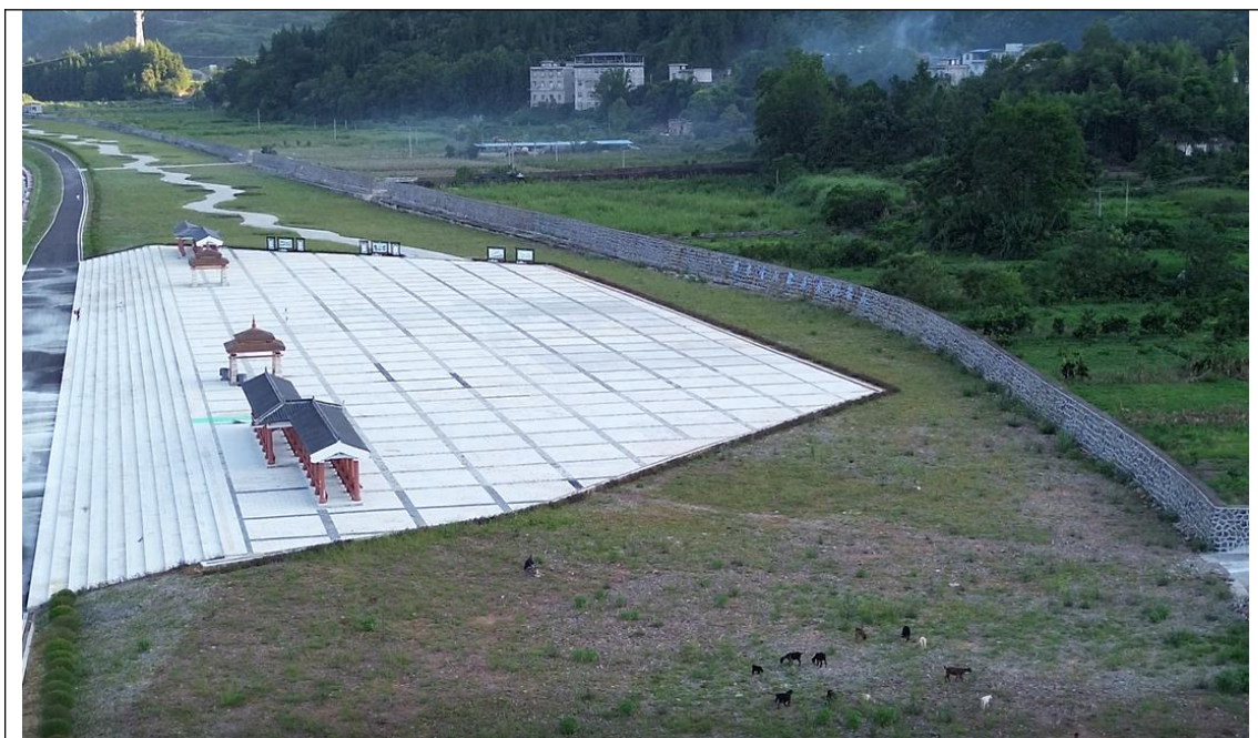
工程上段生态措施恢复现状图
