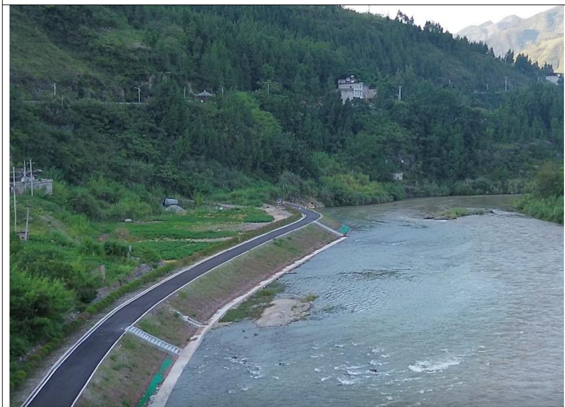
工程上段生态措施恢复现状图
