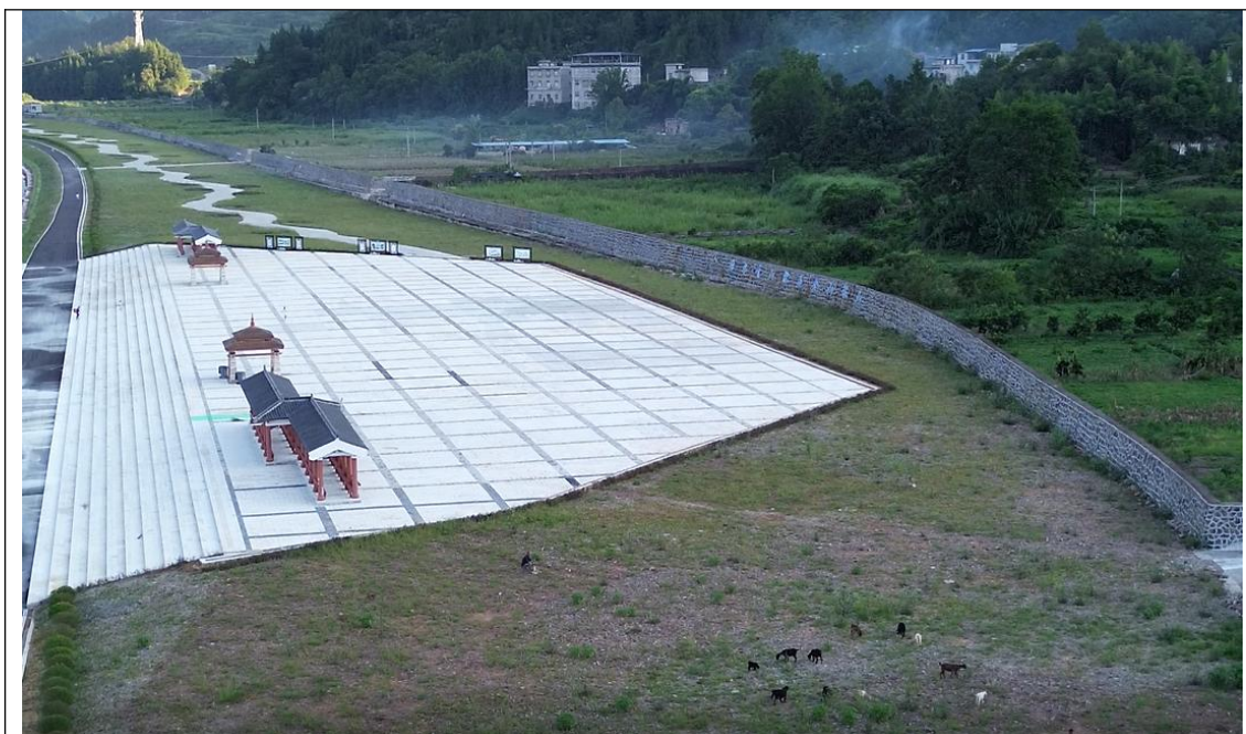
工程上段生态措施恢复现状图
