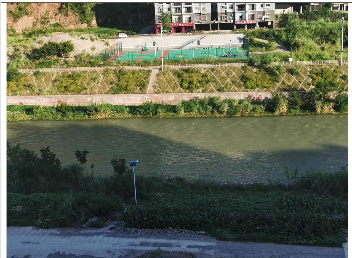
工程中段生态措施恢复现状图
