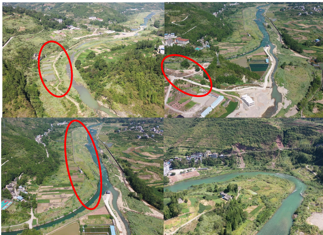
图 2.2.3-1 工程河段现状部分天然岸坡段防洪不达标
