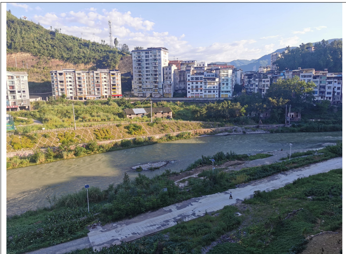
工程上段生态措施恢复现状图
