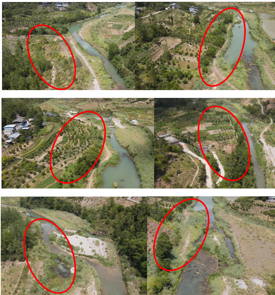
图 2.2.3-1 工程河段现状天然岸坡段防洪不达标
